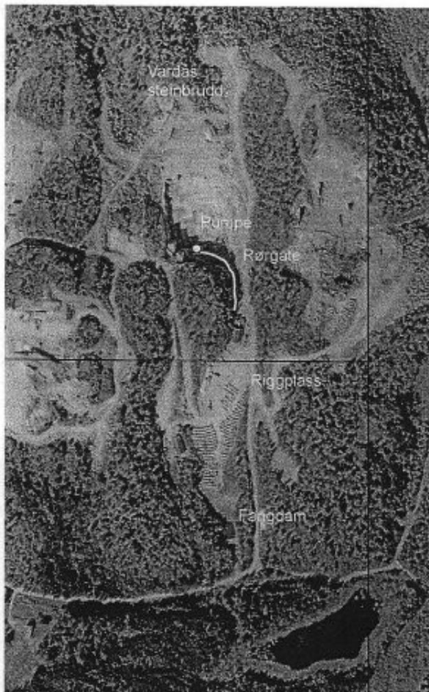
Fig. 2. Illustrasjon hvordan dagens situasjon er i forhold til behandling av overskuddsvann fra Vardås steinbrudd.
